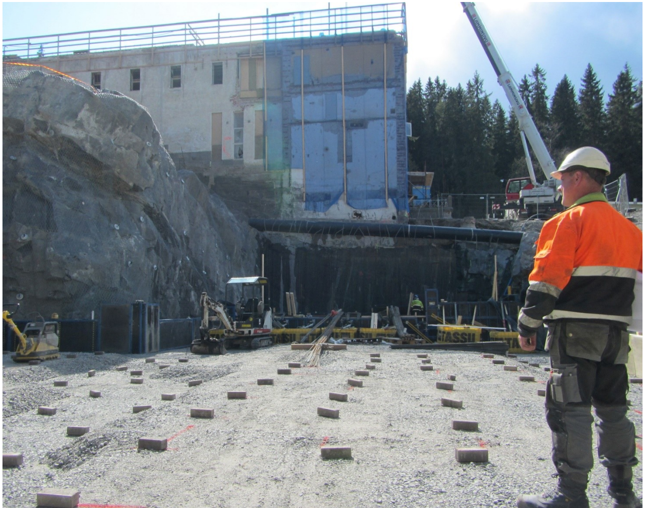
Kuva 3 Rakennusurakoitsijan johtaja tarkastaa tulopumppaamosiiven pohjatöitä.
