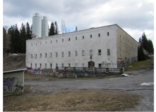
Kuva 1 Kaupinojan laitoksen julkisivu 2010.
